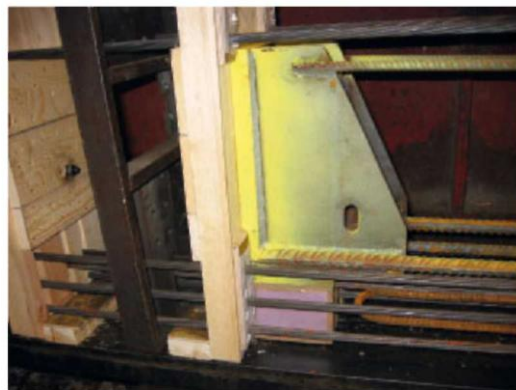
Рисунок 12 Пример дополнительной арматуры и крепления башмака балки РС перед формовкой
